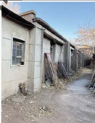
③建筑南立面及门洞口 (一)
