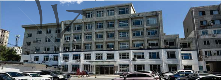
④建筑南立面及门窗洞口
