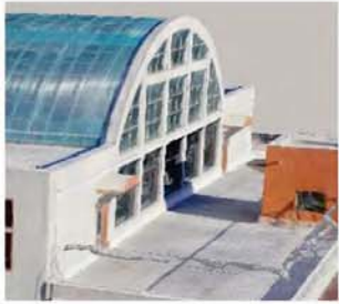
⑧建筑北立面及门窗洞口2
