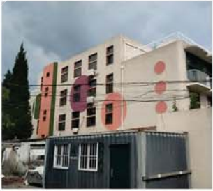
⑥建筑西立面及窗口
