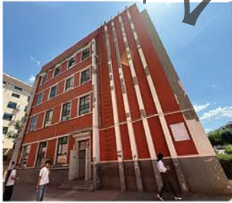
④西立面、窗洞口及线脚
