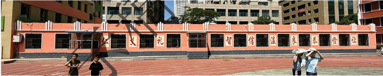
②建筑东立面及门窗洞口
