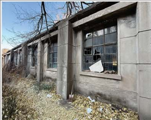
③建筑南立面及门洞口 (二)
