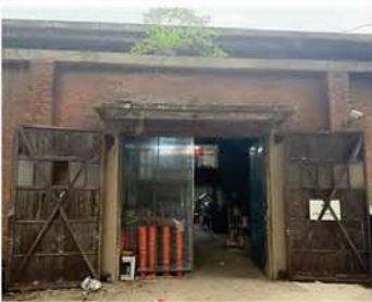
⑧建筑壁柱、横向装饰及门洞口
