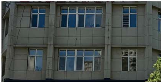
⑦建筑立面壁柱
