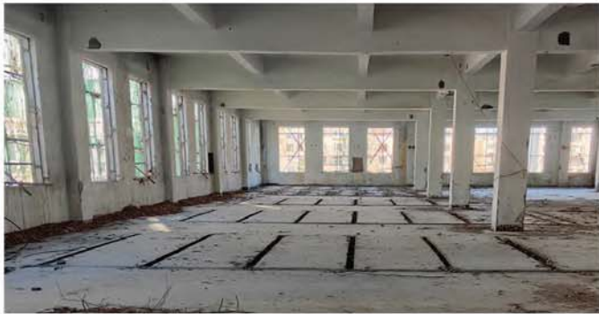
④二层混凝土框架结构及楼板
