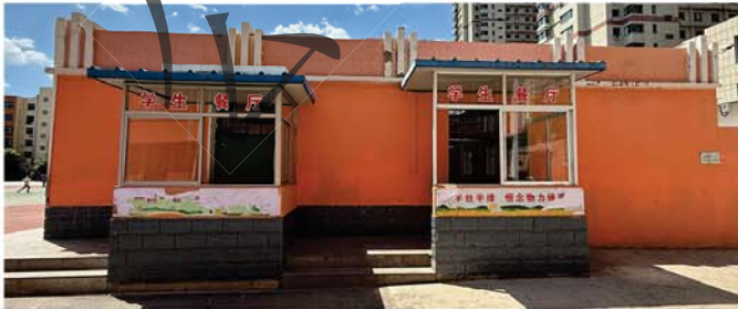
③建筑北立面及门洞口
