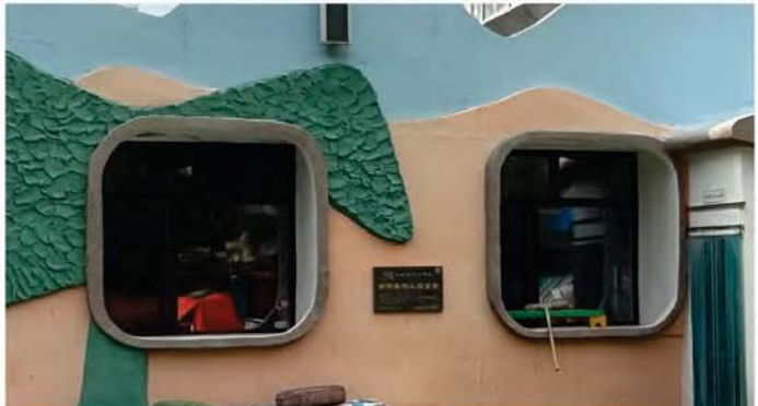
④建筑东立面窗洞口尺度2
