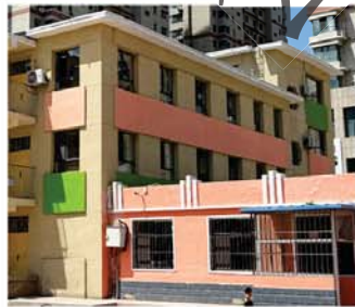
④北立面、窗洞口及线脚
