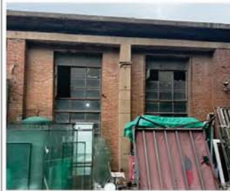
⑦建筑壁柱、横向装饰及窗洞口
