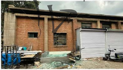
④建筑南立面及门窗洞口 (一)
