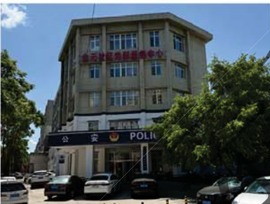
②建筑正立面及门窗洞口
