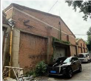
③建筑西立面及门洞口 (二)
