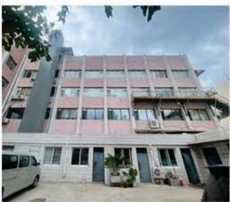
④东立面及门窗洞口
