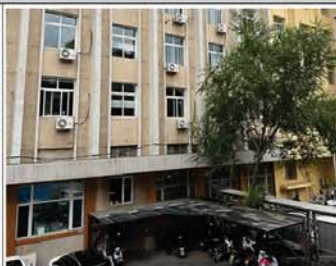
⑧建筑南侧树木
