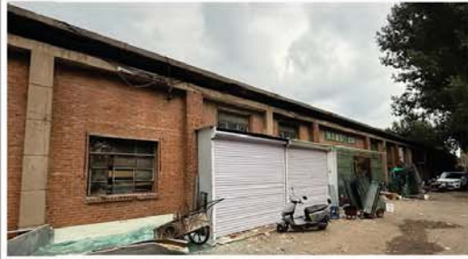
④建筑南立面及门窗洞口 (二)
