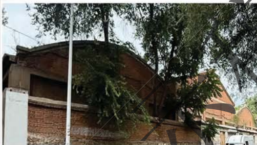
②建筑东立面
