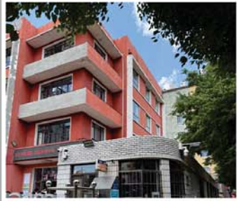
⑤东立面、窗洞口及线脚
