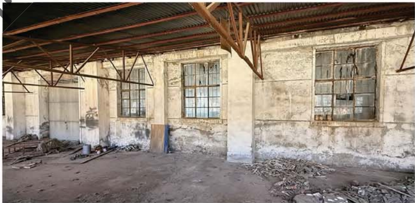
③建筑北立面及门窗洞口
