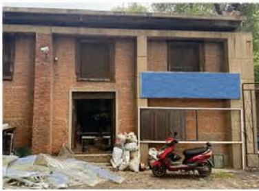
⑨建筑壁柱、横向装饰及门洞口
