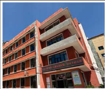
⑧东南侧入口及阳台
