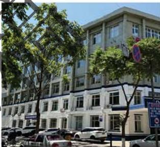
③建筑北立面及门窗洞口
