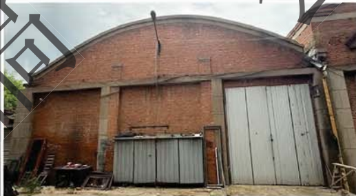
③建筑西立面及门洞口 (一)
